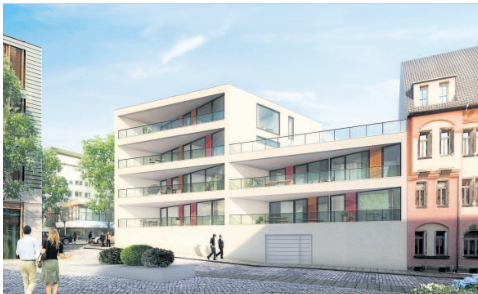
Ecke Buchenstraße/Kiefernstraße: Sieben Eigentumswohnungen entstehen in dem Haus am nördlichen Ende der Kiefernstraße. 2,3 Millionen Euro soll der Neubau kosten. Die Fertigstellung ist für Sommer 2013 geplant.
