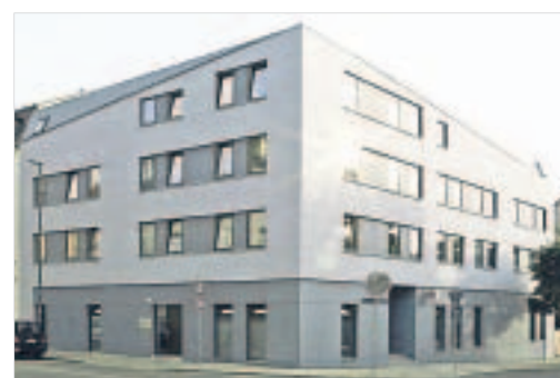
Rudolf-Leonhard-Straße 64/66: Im Erdgeschoss hat eine Tierklinik ihren Sitz. Die Dachfläche auf den Straßenseiten klappt zur angrenzenden Bebauung mit einer Neigung von 60 Grad ab.
