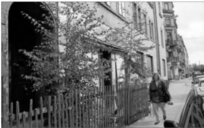
1991: Die Hechtstraße 20 kurz nach der Wiedervereinigung. Die Ruinen wurden nur notdürftig abgesperrt.
